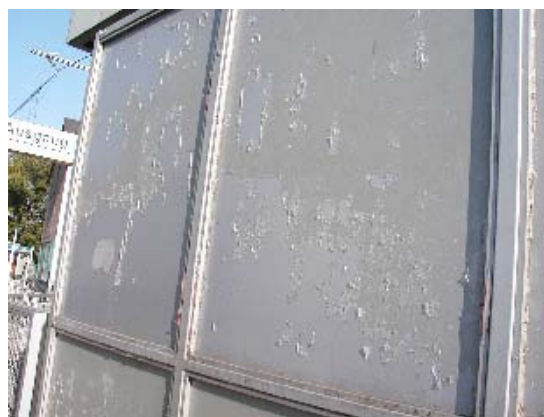
Foto: Dortmunder Stadtwerke
