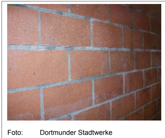
Abb. 1: Strahlschaden (Naßstrahlverfahren) Zu hoher Druck und zu geringer Abstand
