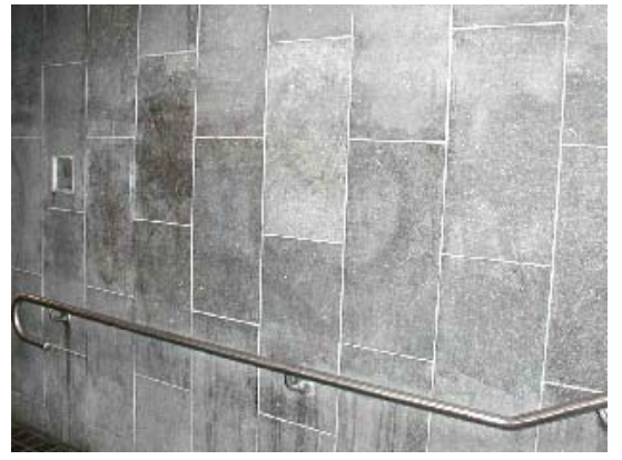
Foto: Dortmunder Stadtwerke
